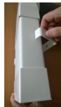
Rys.3 Montaż uchwyty mocującego
