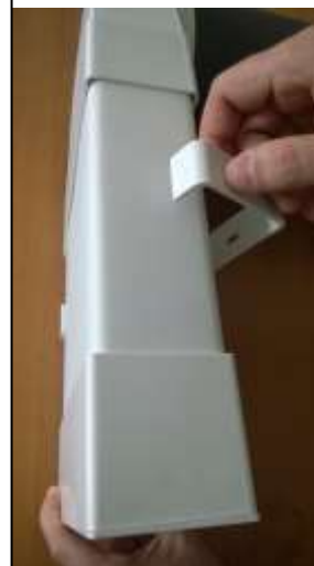
Rys.3 Montaż uchwytu mocującego
