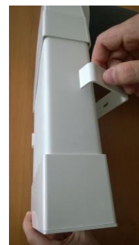
Rys.3 Montaż uchwyty mocującego
