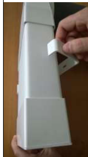
Rys.3 Montaż uchwytu mocującego
